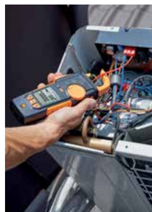
Подвешивание токоизмерительных клещей к наружному блоку холодильной установки.
